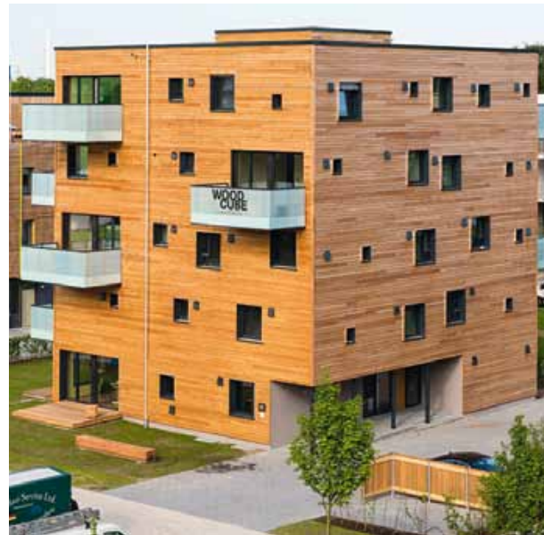
Wood-Cube, gebaut im C2C Design © grimmenstein
